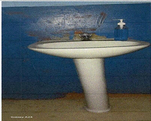
Foto 1: Mejoramiento de Servicios sanitarios y sus accesorios
