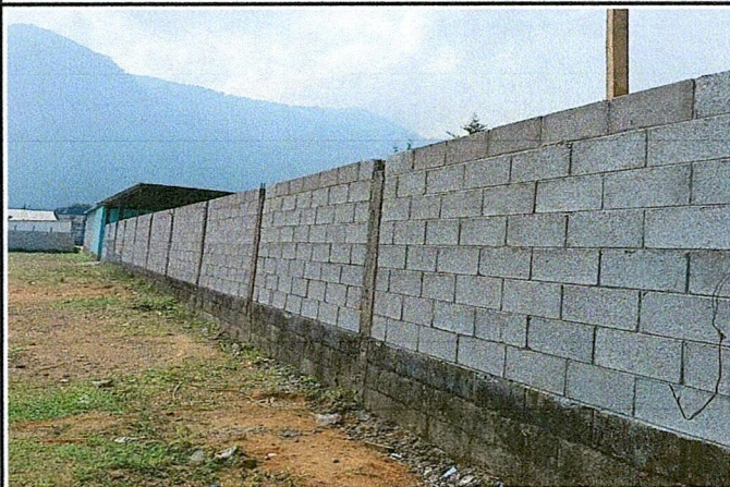
Foto 3: Finalización de Mjoramiento de Muro Perimetral
